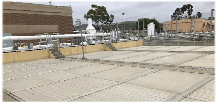
J. B. Latham WWTP
