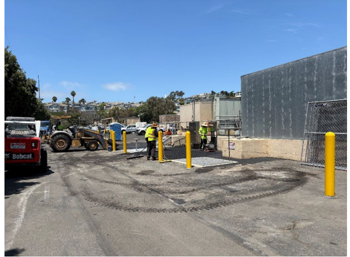
JBL Effluent Area Asphalt Installation
